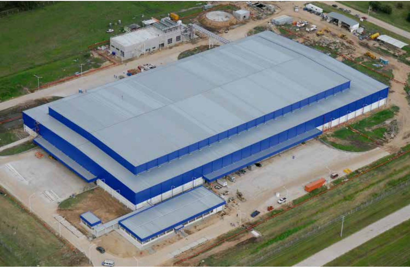
CÁMARAS DE CONGELADOS SWIFT ARGENTINA S.A. | Pilar, Buenos Aires.
