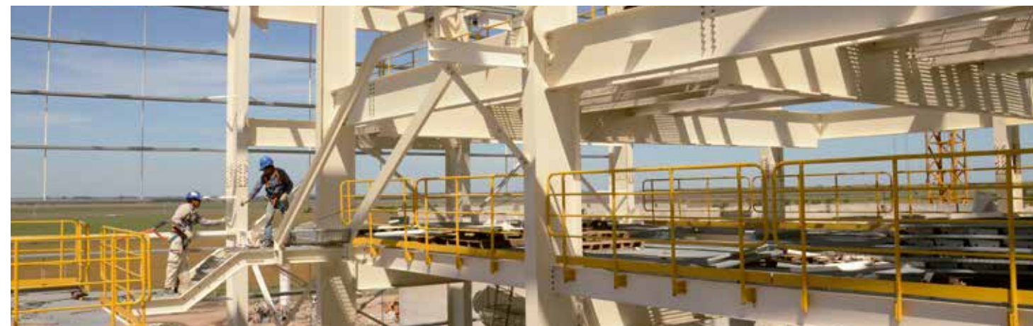
PLANTA DE MOLIENDA Y PROCESAMIENTO DE SOJA RENOVA | Timbúes, Santa Fe.
