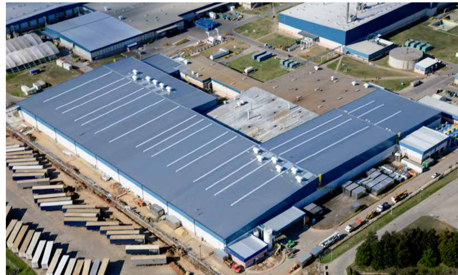
PLANTAS AUTOMOTRICES. NUEVO EDIFICIO DE MOTORES.
